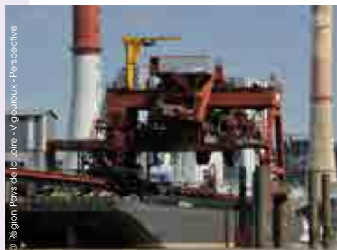
Centrale EDF de Cordemais (44)
