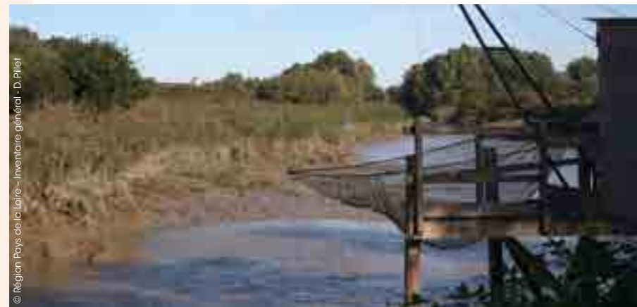
Le port d'étier de Port-Lavigne à Bouguenais (44)
